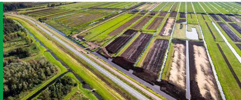
Werkzaamheden polder Den Hoek vanuit de lucht
