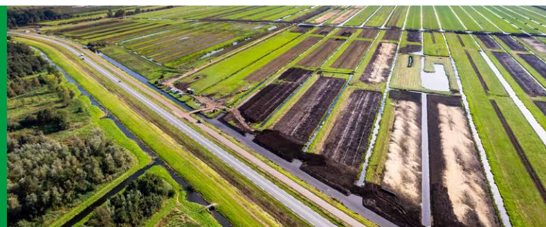
Werkzaamheden polder Den Hoek vanuit de lucht
