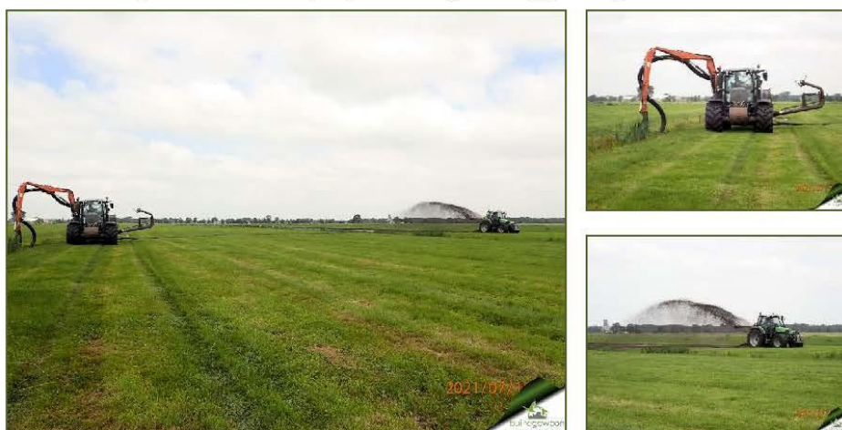
Figuur 10. Baggerwerken met verpompen via tussen rijdende tractor op aangrenzend perceel buiten de pilot.
